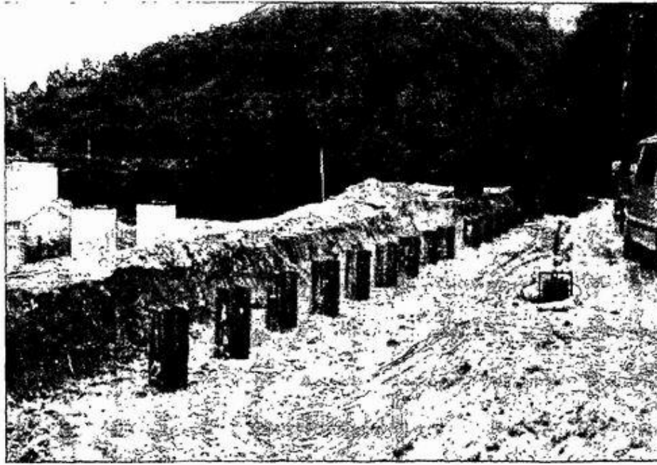
사진 6.29 말뚝항타가 종료된 교대 말뚝(교대 1)의 모습 말뚝의 항타가 완료된 후 말뚝의 정재하시험을 수행하였다. 정재하시험은 연직정재하와 수평정재하시험으로 교대 1 및 교대 2에서 각각 수행하였다. 자세한 내용은 7-9 장에 수록하였다.
